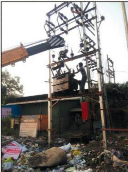
काळे ओढा, बालाजी पार्क आणि गोल्डन सोसायटी या भागात 100 KV चे दोन व 200 KV चा एक ट्रान्सफॉर्मर बसवण्यात आले
