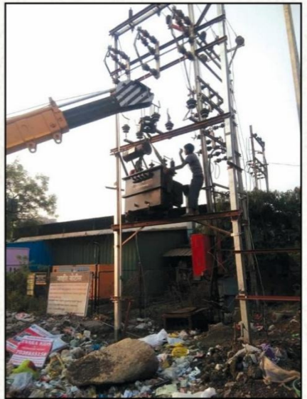
काळे ओढा, बालाजी पार्क आणि गोल्डन सोसायटी या भागात 100 KV चे दोन व 200 KV चा एक ट्रान्सफॉर्मर बसवण्यात आले
